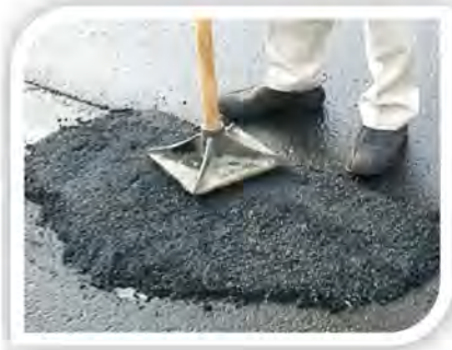
面の締め固めには四角タイプ
